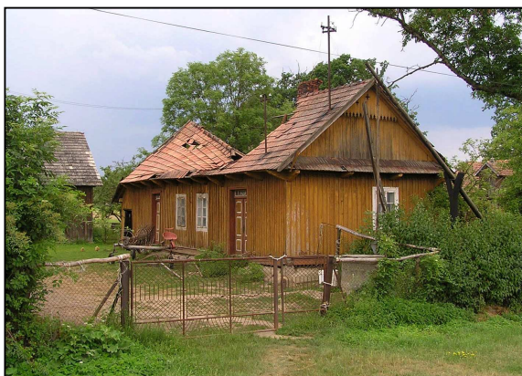
Fot. 28. Zabawa, dom mieszkalny o cechach zabytkowych. Obiekt niezamieszkały w skrajnie złym stanie technicznym
